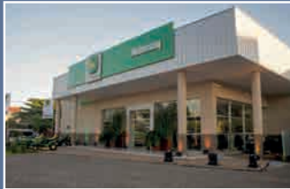
CASA CENTRAL - FERNANDO DE LA MORA
